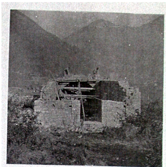
Voûte et abside en reconstruction.
