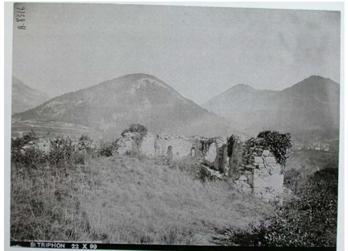
Vue vers Ollon, avant tous travaux.
